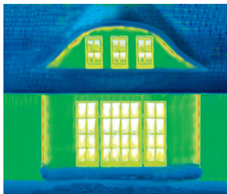
Efter renovering: Minimeret energitab med Nordic Design Plus vinduer.
